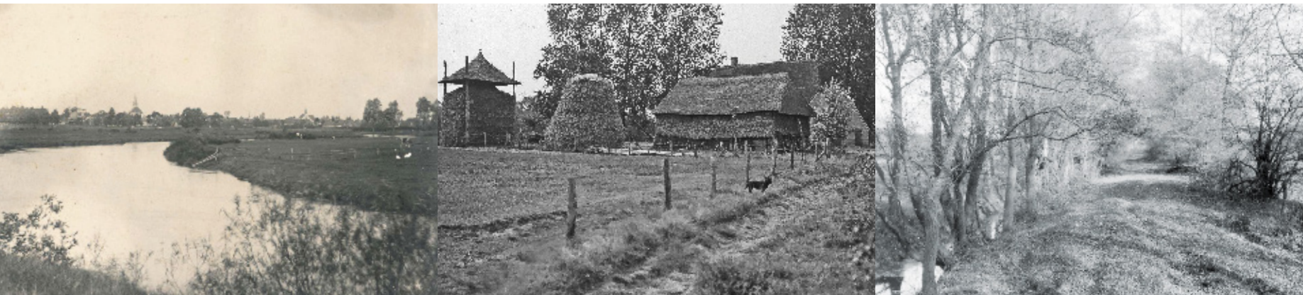
In deelgebied B zijn de kades laag, zoals hier bij Ommen.
